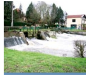
Centrale Hydraulique du moulin l'Evêques
