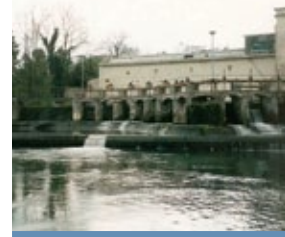
Centrale de la Cahoterie
